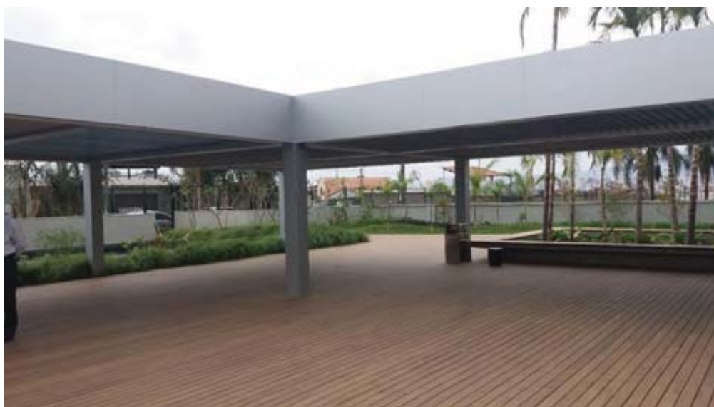
Vista externa do térreo
