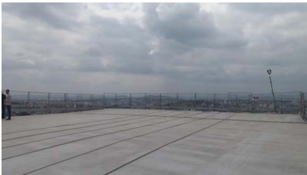
Vista geral da cobertura do edifício
