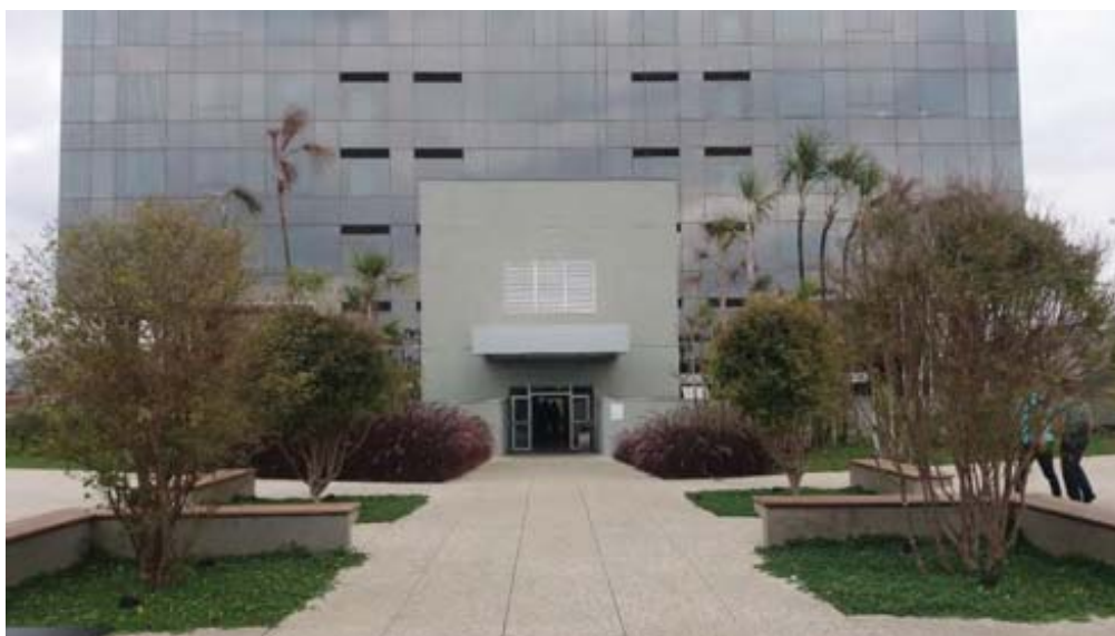
Vista do acesso ao edifício
